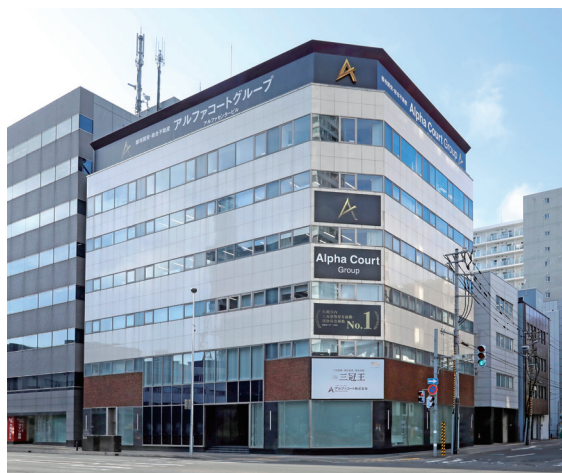
アルファセンタービル
