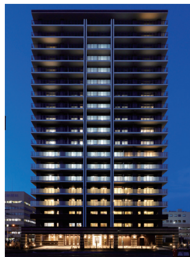
帯広市西3・9周辺地区第一種市街地再開発事業 (分譲マンション棟)
