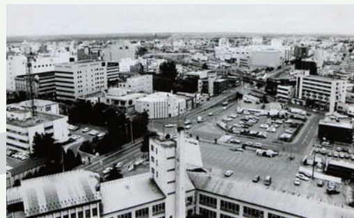
⑨ 建設中の帯広市役所／市庁舎から 高い建物が目立つようになった帯広の中心市街地。手前に建つのが旧市役所。遠くにイトーヨーカドーが見えます。
